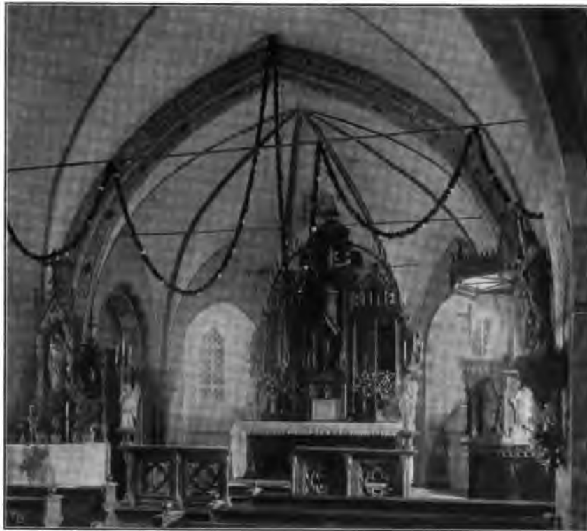
Innenansicht nach Osten.
